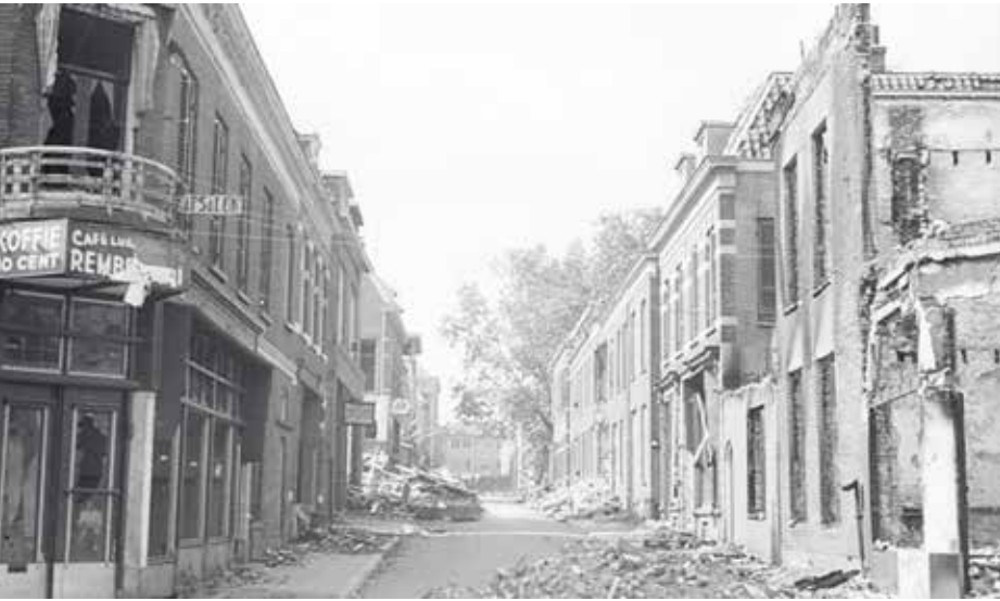
De schade in de Bloemstraat
