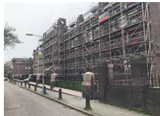
Het gebouw dat in de steigers staat, en het roze marmer van de omheining.
