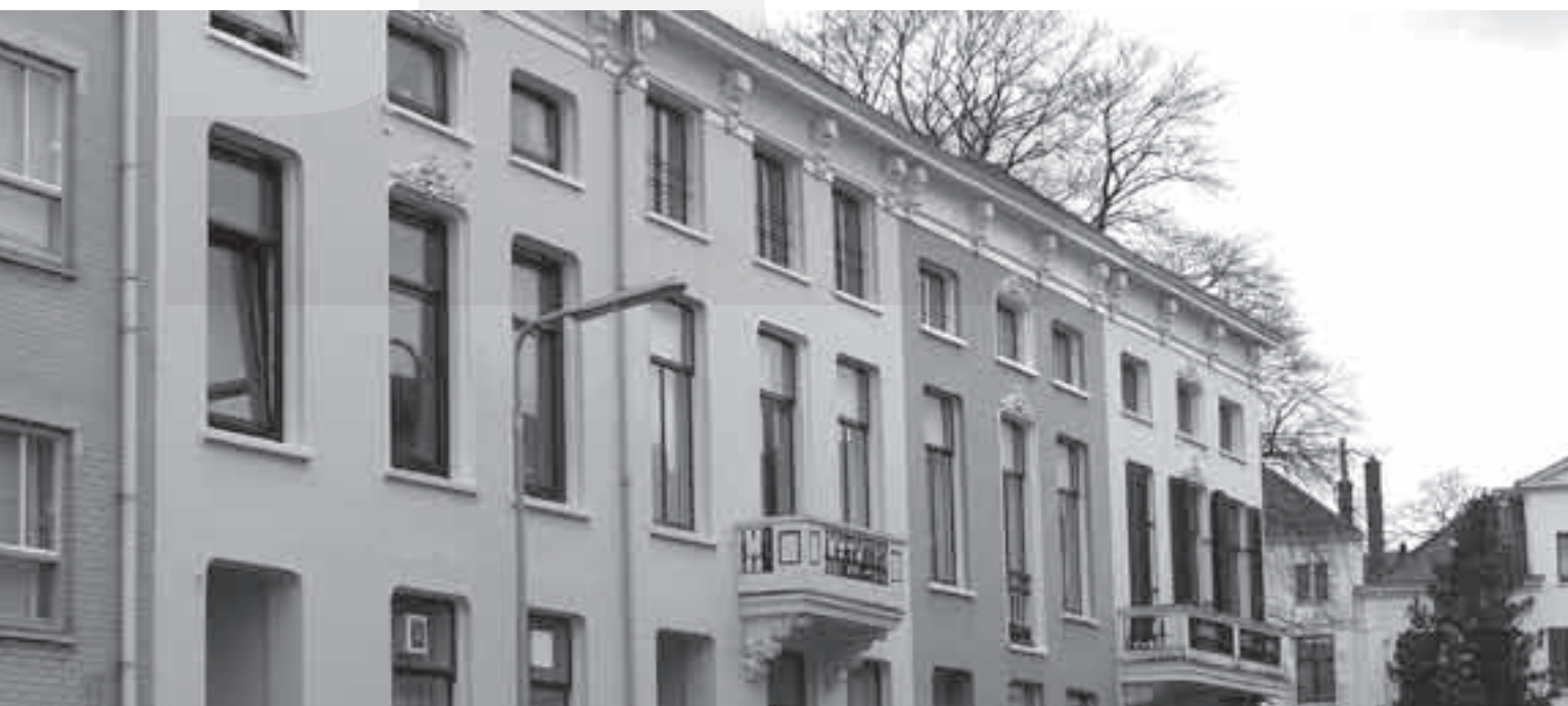
Een rijtje panden met mezzanines.
