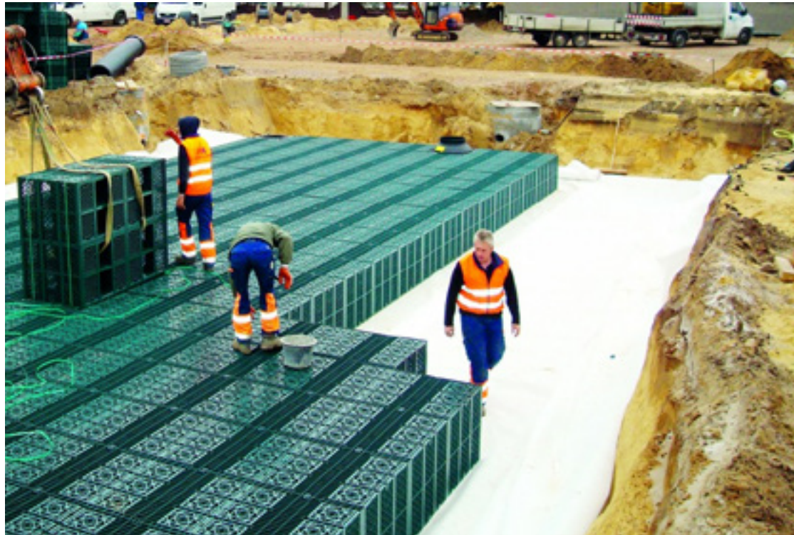
Figuur 9.03 Www.indra-infra.com, M. (2006, February 07). plaatsen van infiltratiekratten. Retrieved from https://www.rainproof.nl/toolbox/maatregelen/infiltratiekratten
