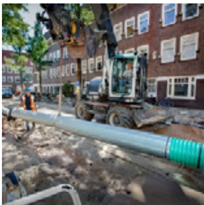
OMGEKEERDE DRAINAGE/ RIOOL
