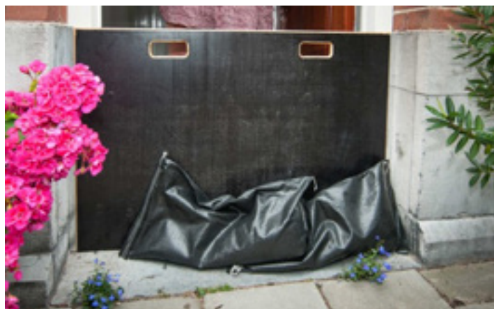
Figuur 5.22 Doodkorte, M. (2015, July 29). Schot met zandzakken. Retrieved from https://www.rainproof.nl/regenbestendig-souterrain
